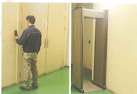
三重の入退室管理システムなど 日本同等のセキュリティシステムを完備
